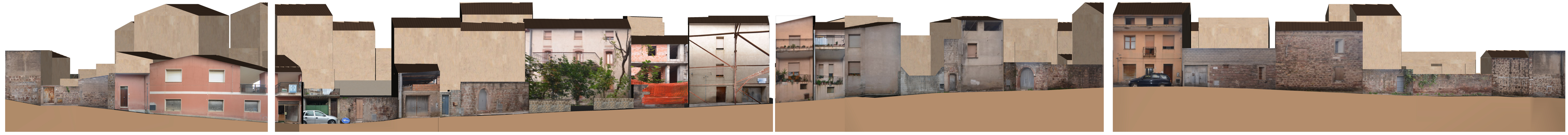
PROFILO A_A Via Umberto I PROFILO B_B Via Roma PROFILO C_C Via Montenegro PROFILO D_D Via Giuseppe Mazzini
